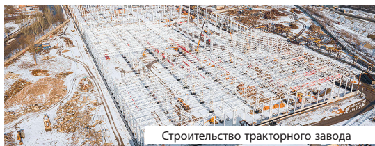
Строительство тракторного завода
